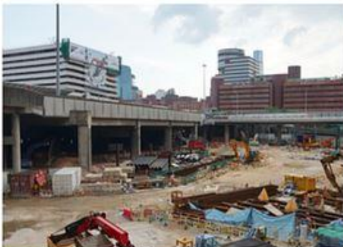
提供滅火氣體設計安裝服務
